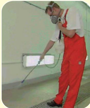
定評のある壁用コーティング材ダストイーターを進化させた床専用コーティング剤 塗装室及びその周辺の床に(噴霧器)でコーティングします
