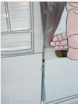
◀前記説明の通りに加工したココネートチューブをドアの外側で隙間部分にあてがう
